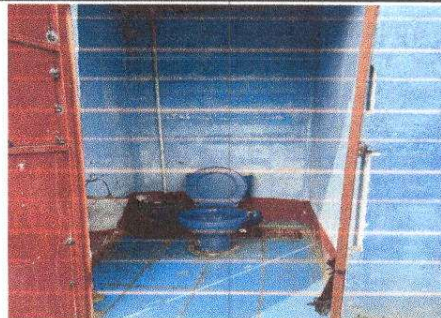
Foto 10: Servicios sanitarios, Sustitucion de inodoro, piso y azulejo.
