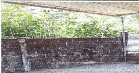
Foto 7: Reparacion de muro perimetral de block.
