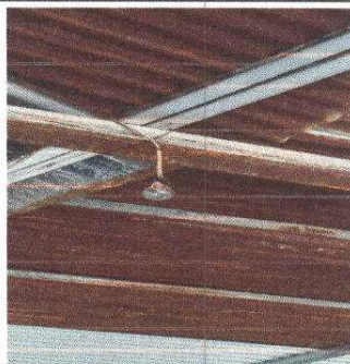
Foto 4: Sustitución de lampara tipo led.
