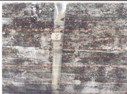
Foto 5: Sistema eléctrico. Sustitución de toma corriente doble.
