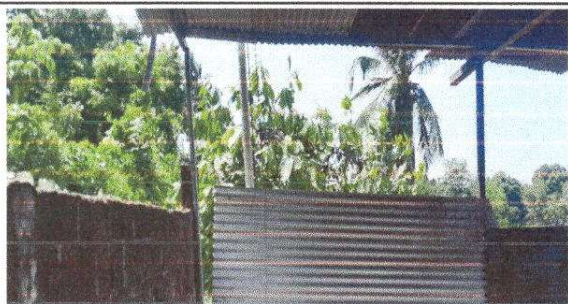
Foto 3: Sustitución canal de metal
