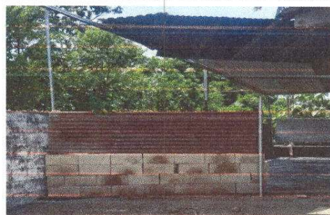
Foto 6: Reparación de muro perimetral de block.
