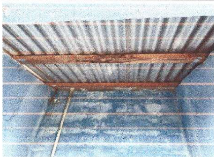
Foto 9: Cubierta de lamina, sustitucion de lamina troquelada aluzin y estructura de techo de madera por metal .
