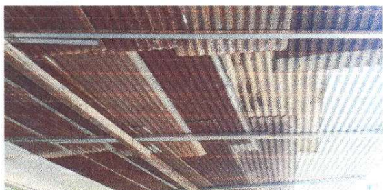
Foto 1: Sustitución de lamina por lamina Troquelada aluzinc c-26, Sustitución de estructura de soporte de metal por metal
